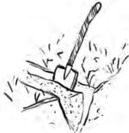
**F** Stich mit einem Spaten ca. 20–25 cm tiefe v-förmige Leitungsgräben aus. Nimm dazu vorsichtig die ausgestochene Grasnarbe ab und hebe den Graben aus. Entferne die Steine aus dem Graben.
